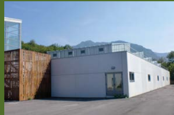
Hospital de la Fauna (Sobrescobio) 5.300.000 €
